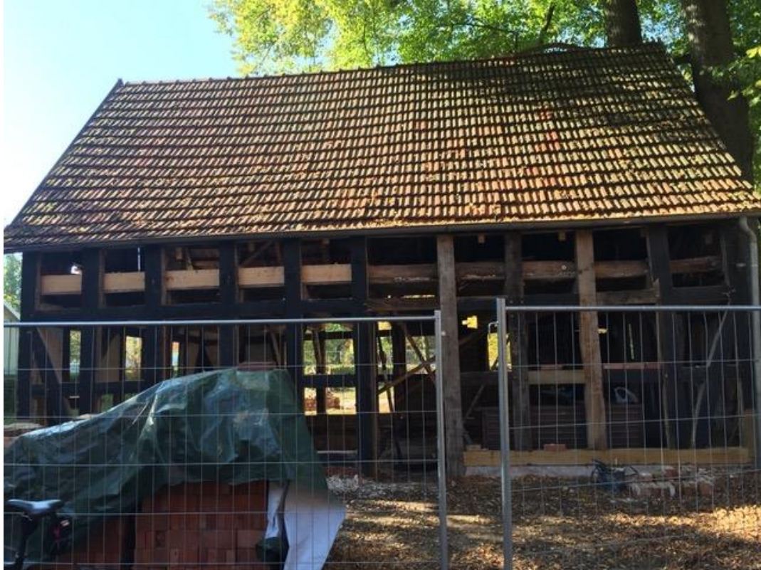
Rechts: Neues Fachwerk, vorher Garagentor; oben: Stabilisierung des Ringankers
