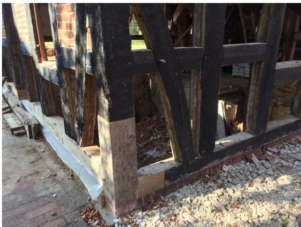
Fachwerk-Ecke meisterhaft restauriert von der Firma „Fach und Werk“
